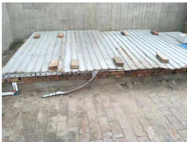
厂区污水处理站
