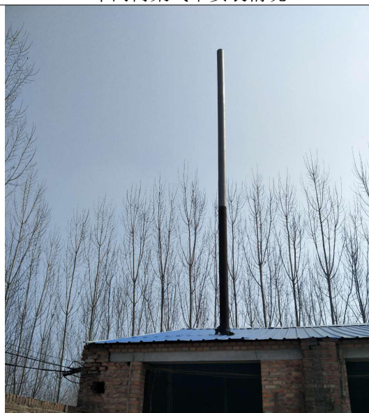
锅炉房对应的排气筒 (P3)
