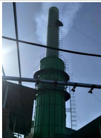
隧道窑焙烧废气对应的脱销脱硫系统+30 米高排气筒
